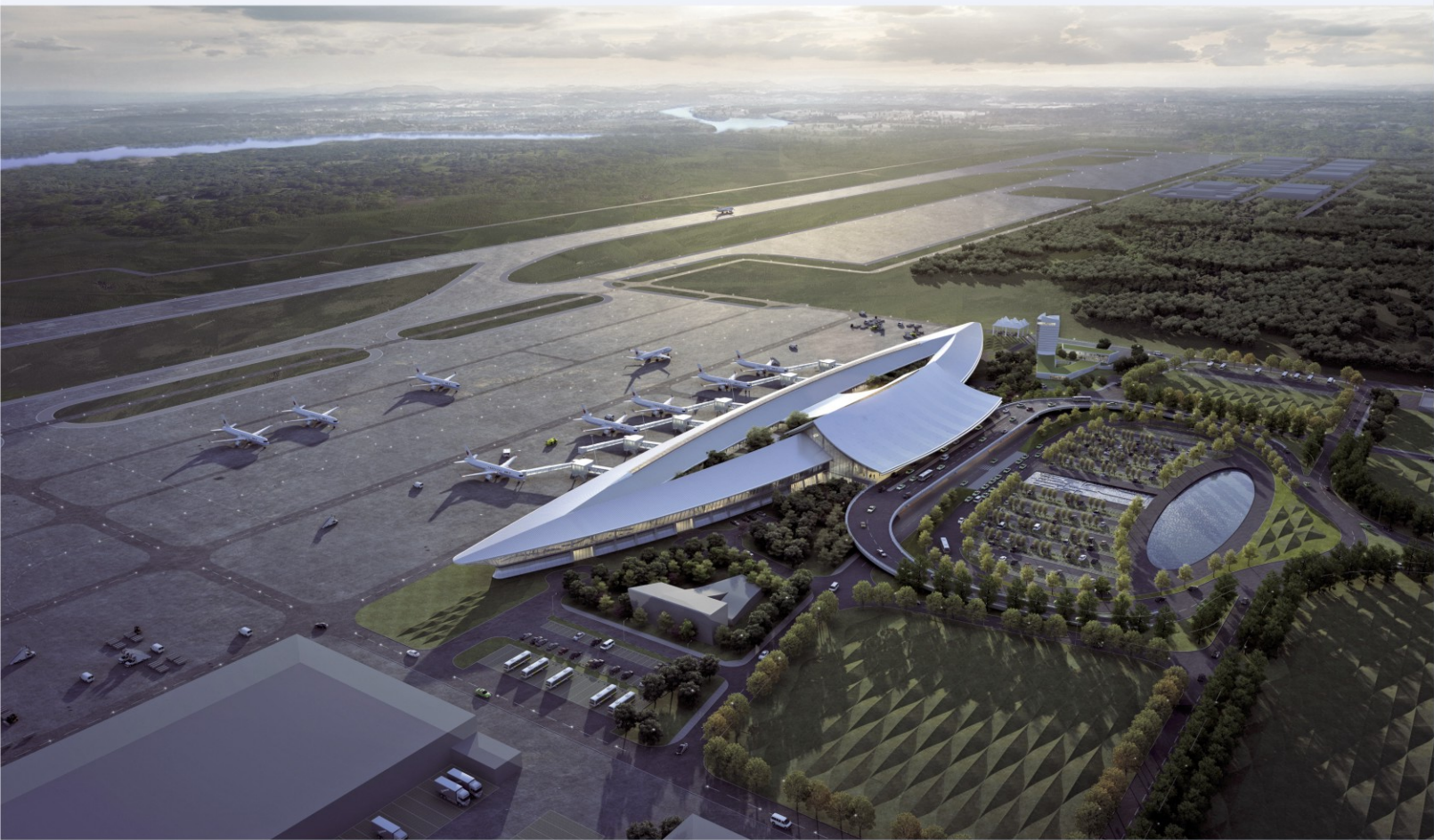
乐山机场民用航站区项目
